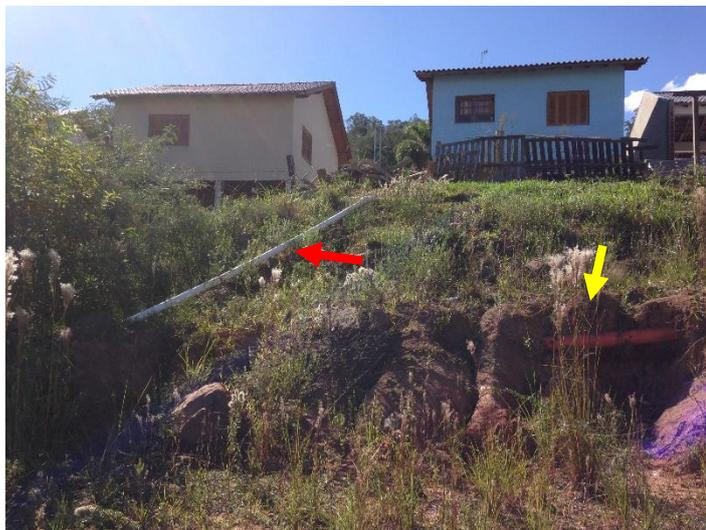
Figura 11: Rede coletora (seta amarela) e a ligação da residência (seta vermelha).
