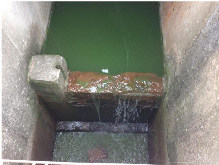
Figura 30: Ponto de saída do esgoto tratado.
